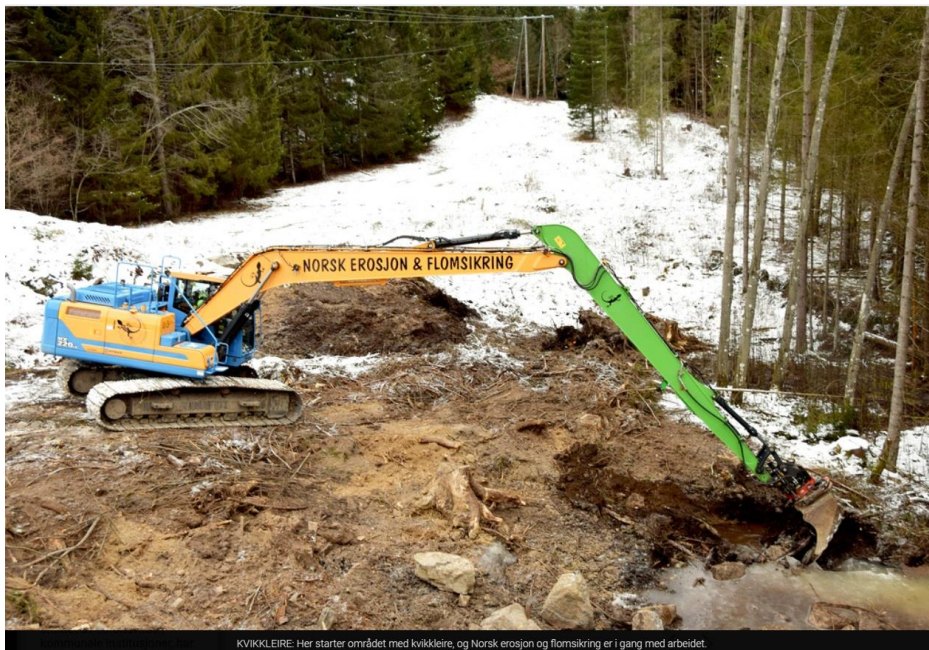
KVIKKLEIRE. Her starter området med kvikkleire, og Norsk erosjon og flomsikring er i gang med arbeidet.
